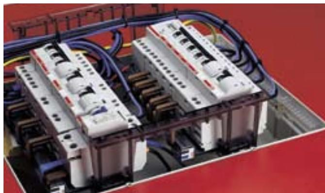
▲ Съемная рама с DIN рейками упрощает кабельную разводку на стене.
